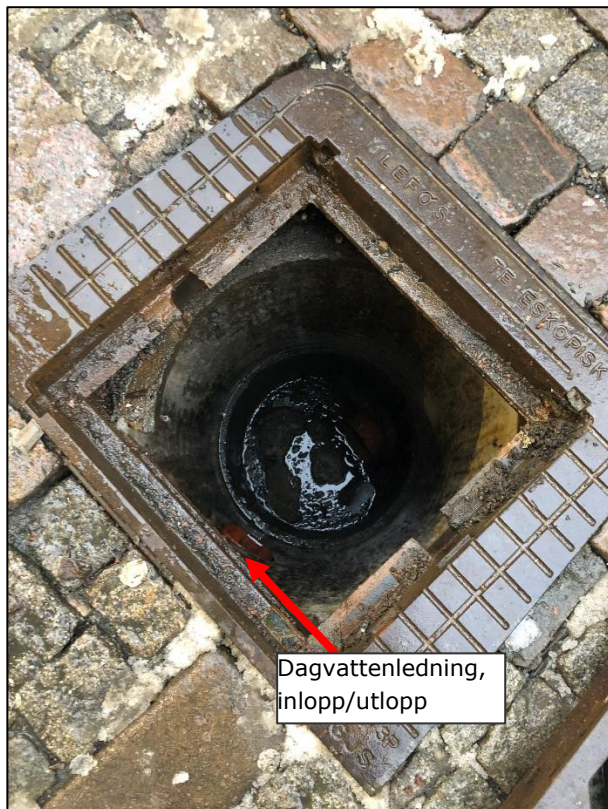
Figur 6. Vattendjupet i dagvattenbrunnen var ca 15 cm. Foto: AFRY
