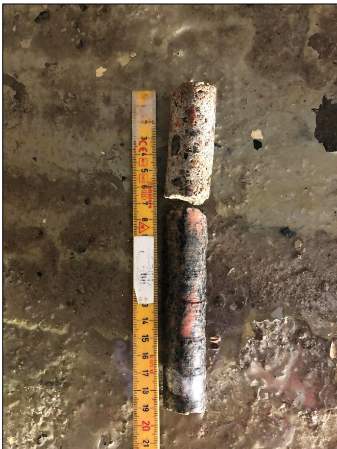
Figur 8. Betonggolvet underlagrades av en granitplatta.
